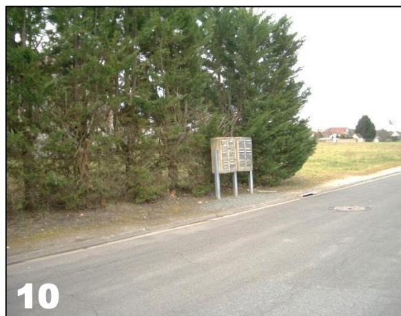
Cidex le long de la rue du Général Leclerc
